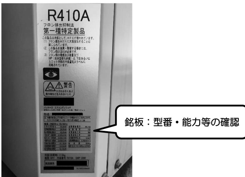
図 2-5 熱源機の型番表示の例（パッケージエアコン空冷式）
