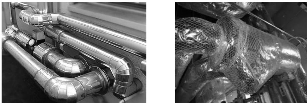
図 2-10 配管保温材の施工
